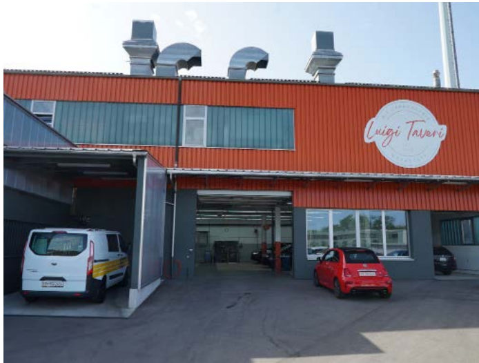
Der Aussenplatz hinter der Werkstatt wurde ausgebaut.
